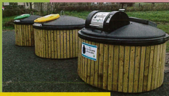
> exemple de colonne semi-enterrée avec habillage bois
